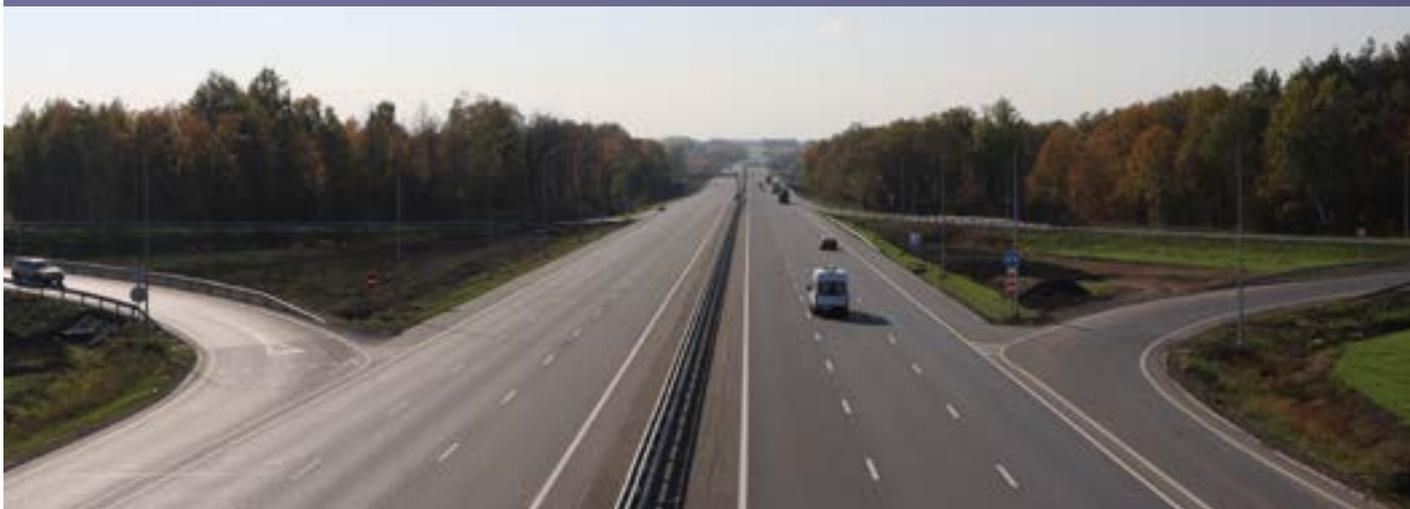
Проезжую часть самого загруженного участка на федеральной сети в границах Башкортостана протяженностью **14,3 км** расширили **с 2 до 6 полос** движения, довели отрезок дороги до нормативов **категории ІБ**. На участке построили **7 искусственных сооружений**, **2 транспортные развязки** по типу «неполный клеверный лист», **реконструировали мост** через реку Юрмаш и устроили **4 площадки отдыха**.
