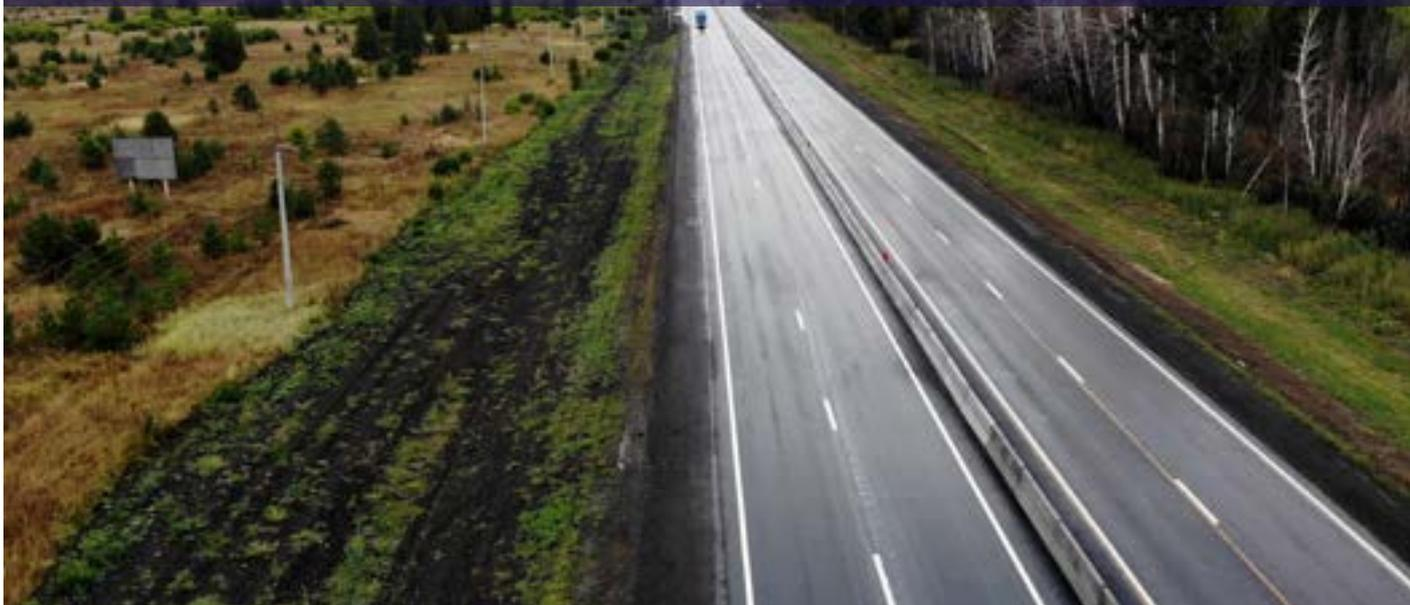
Обновленный участок дороги относится к II категории, имеет **4 полосы** движения с осевым барьерным ограждением. На ремонтируемом отрезке был досрочно выполнен капремонт моста через **реку Синару**.
