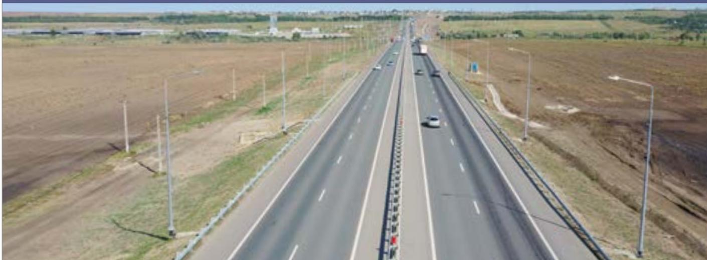
Работы на объекте были начаты в мае 2021 года и закончены **с опережением графика**. Дорожники переустроили все инженерные коммуникации, возвели земляное полотно путем отсыпки свыше **230 тыс.** куб. м насыпи. На новом участке появилась транспортная развязка в разных уровнях, а также 2 моста и путепровод.
