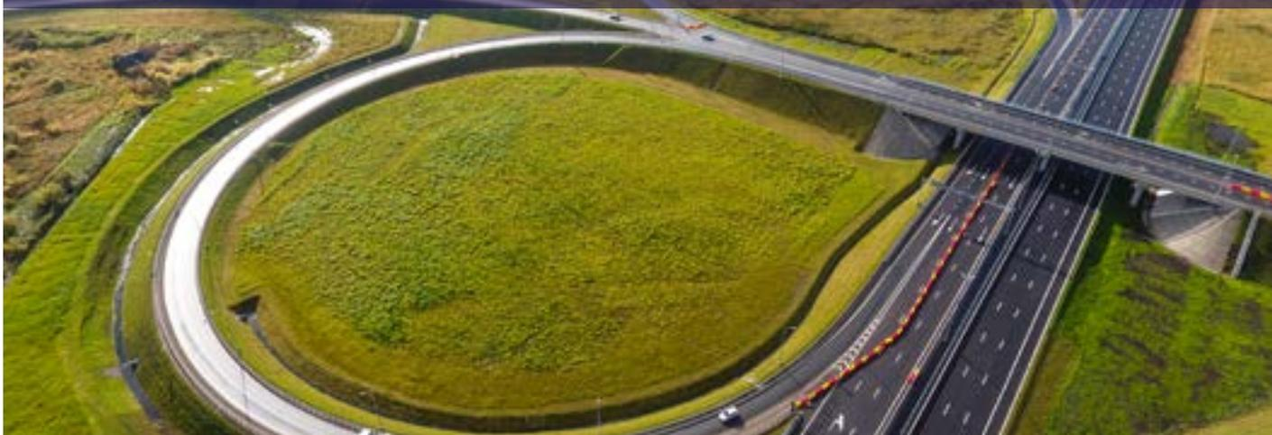
В составе нового **6-полосного участка** трассы возведены **4 путепровода**, в том числе в составе транспортных развязок в разных уровнях. Для повышения безопасности участников движения на данном участке установлены барьерные ограждения, разделяющие встречные потоки, протяженностью около **52 тыс. пог. м**, смонтировано более **20 км линий наружного освещения**, построено **2 надземных пешеходных перехода**.
