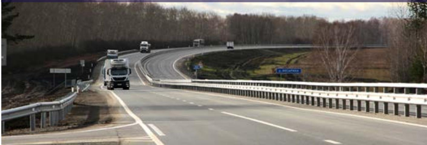
Участок длиной **19 км** возле Камышлова **стал 4-полосным**. Пропускная способность увеличена более чем в 3 раза: **с 6 до 19 тыс. автомобилей в сутки**. Разделение транспортных потоков барьерным ограждением поможет водителям **избежать лобовых столкновений**. Федеральная трасса **Р-351** Екатеринбург – Тюмень соединяет столицы двух субъектов Российской Федерации и входит в состав европейского транспортного маршрута **Е22**.
