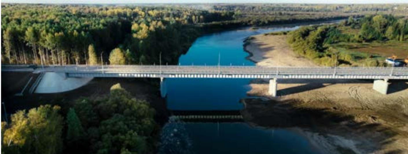
Мост через реку Яю построен **взамен старого предаварийного** и соответствует современным нормативным требованиям грузоподъемности. Благодаря новому искусственному сооружению удалось наладить **непрерывное движение** легкового и грузового транспорта по автомобильной дороге Больше-Дорохово – Тегульдет.
