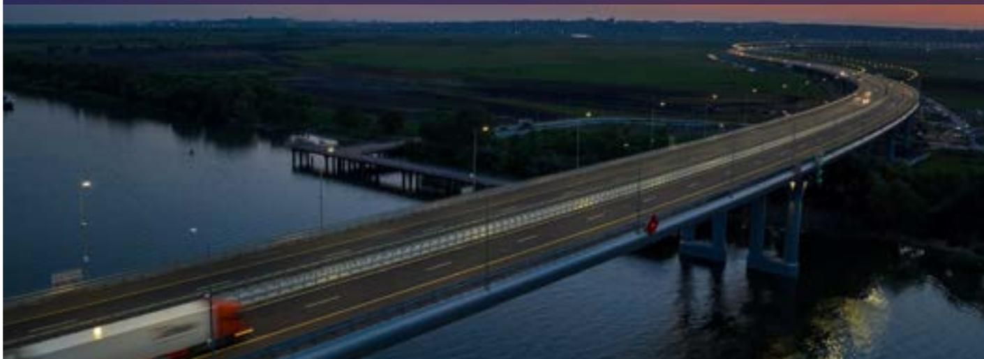
Строительство и реконструкция **65 км** восточного обхода Аксая выполнены в рамках развития дальних автомобильных подходов к Крымскому мосту **на 18 месяцев ранее** запланированных сроков. Трасса М-4 «Дон» расширена **до 6 полос**. Возведен **мост** через реку Дон с **2 полосами** движения в каждом направлении. Возросла пропускная способность участка, повысилась безопасность движения за счет сокращения транзитного трафика.
