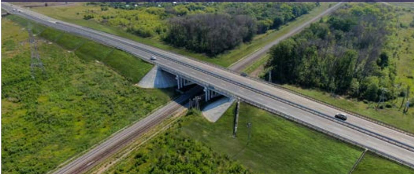
Проезжую часть расширили **с 2 до 4 полос**. Встречные потоки на обходе разделены осевым барьерным ограждением, построены 3 новые разворотные петли, которые ликвидируют самые опасные — левые повороты.
