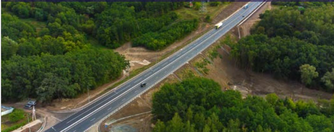
Главным итогом работ стало увеличение количества полос движения **с 2 до 4** и установка разделительного барьерного ограждения. Расширение проезжей части произошло **впервые** за весь срок службы построенной дороги, который составил **более 50 лет**.
