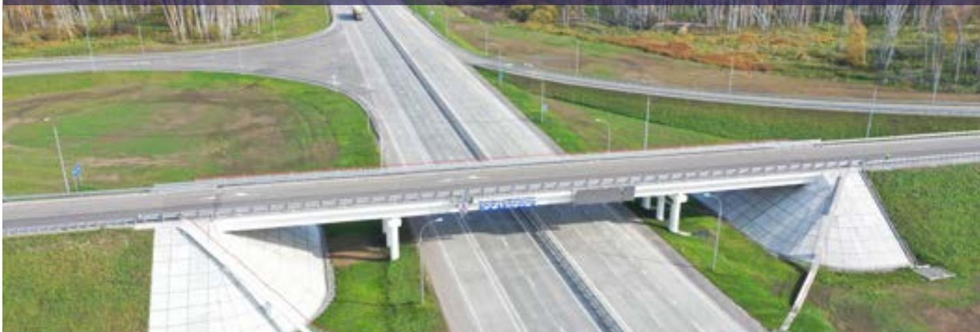
Завершили реконструкцию **30-километрового** участка дороги **Р-254 «Иртыш»**. Проезжую часть **расширили с 2 до 4 полос движения**, установили барьерное ограждение. Возвели **6 транспортных развязок** и **7 мостовых сооружений**, а также построили **10 км** новой дороги в обход поселка **Коченёво**. Участок в режиме онлайн открыл Председатель Правительства РФ Михаил Мишустин.
