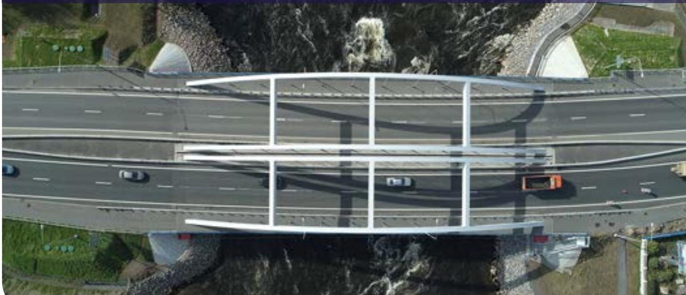
Украшенный архитектурно-художественной подсветкой мост через **Вуоксу** имеет **2 отдельных арочных пролетных строения** индивидуального проектирования с гибкими подвесками из высокопрочных вант.
