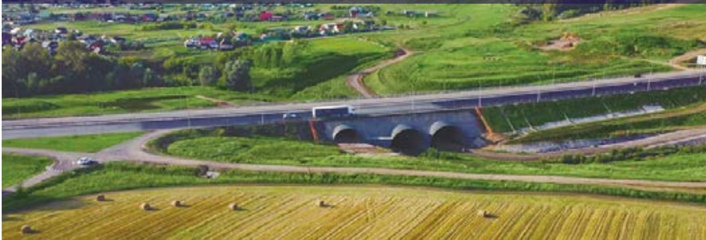
Протяженность участка — **11 км**. В ходе реконструкции 2-полосная дорога доведена до **6 полос**, построена **разноуровневая транспортная развязка** рамочного типа на примыкании к автодороге к поселку Сергеевка. Также **отремонтирован арочный мост** через реку Малый Кидаш, устроены скотопрогон и тоннель для проезда сельхозтехники ниже уровня трассы. Возле поселка Восточное возведен надземный **пешеходный переход**.
